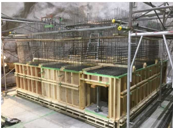
図2.6.2 施工状況 2.6.19 Fig. 2.6.2 Status 2.6.19
