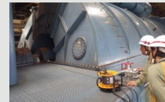
若手保守員の火力研修 タービンロータ振動測定
