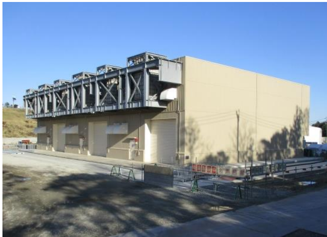
緊急時ガスタービン発電機建屋
