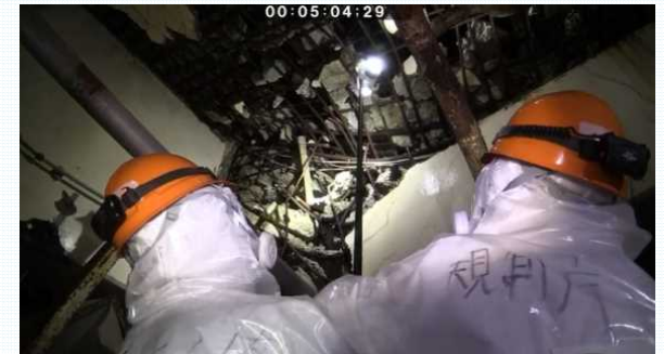
3号機原子炉建屋内調査(令和2年9月)
