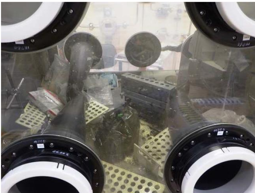
図2 火災があったグローブボックスの内部
