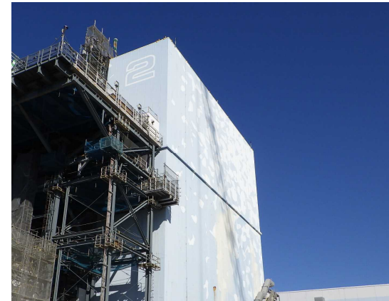
2号機原子炉建屋 点検写真例（南側）
