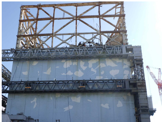
1号機原子炉建屋 点検写真例（北側）
