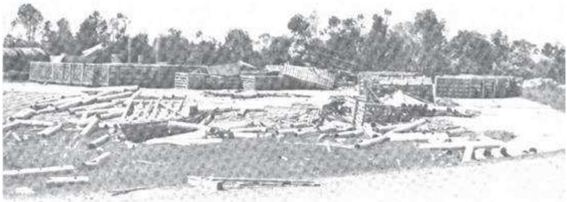
図 33 Grand Gulf 原子力発電所資材置き場におけるパイプの散乱状況
