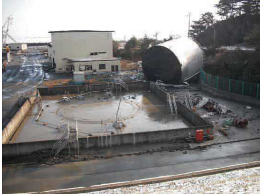
写真 4. 2-1 (8) 敷地内で確認された東北地方太平洋沖地震に伴う津波の漂流物 (0. P. +2. 5m に設置されていた第 1 号機補助ボイラー用の重油貯蔵タンク)
