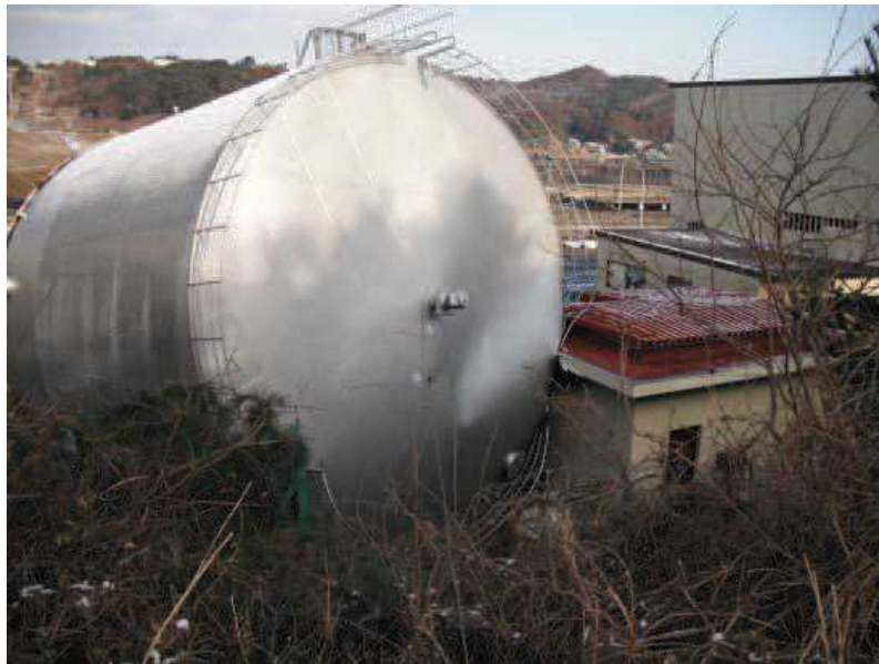
写真 4. 2-1 (9) 敷地内で確認された東北地方太平洋沖地震に伴う津波の漂流物 (0. P. +2. 5m に設置されていた第 1 号機補助ボイラー用の重油貯蔵タンク)
