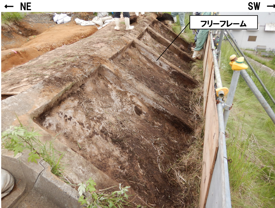
開削調査箇所（南側）海側壁面 フリーフレーム撤去前の状況（令和元年5月撮影）
