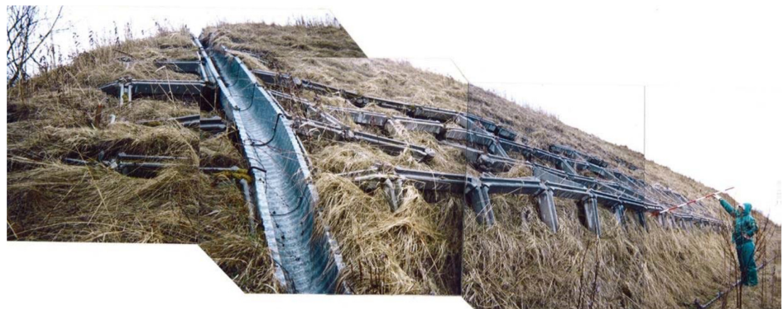
道東地域における凍上による斜面の変状 地盤工学会 (2010) より抜粋
