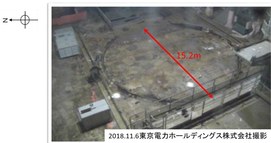
図5 2号機のおペフロの状況(2018年11月6日)
