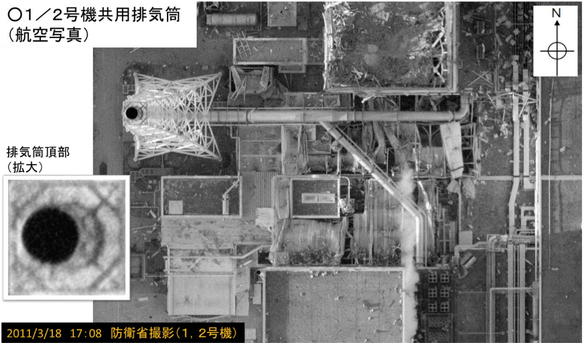
図5 1/2号機 SGTS 配管系の建屋外の状況 (航空写真)
