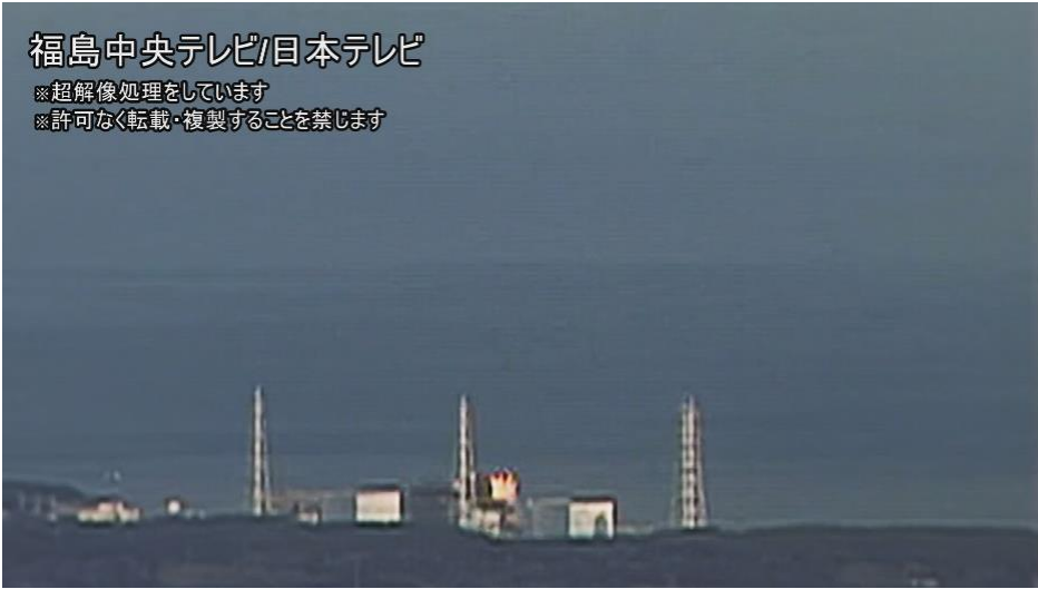
図 7-4 3号機における水素爆発時の原子炉建屋上部の火炎の状況 1/60 秒
