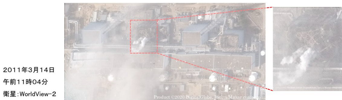
図 2 福島第一原子力発電所1号機~4号機の衛星写真
