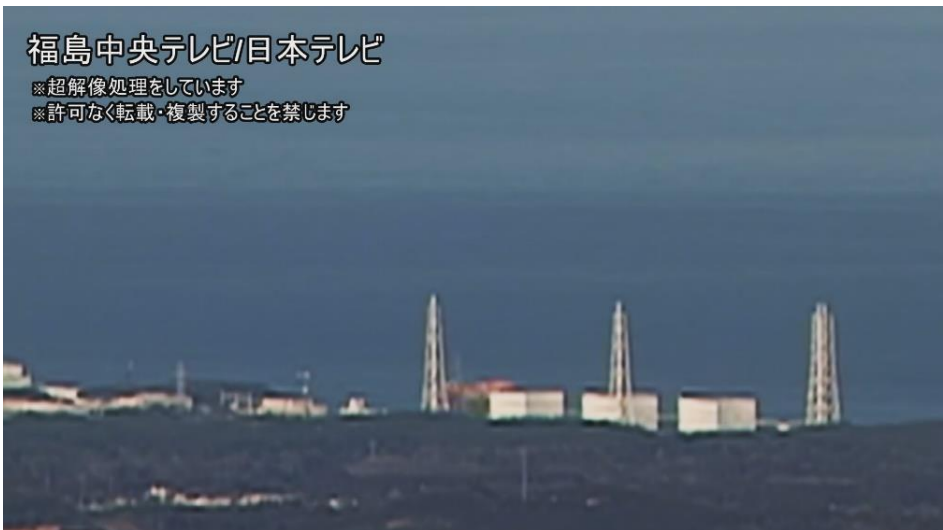
図6—4 1号機における水素爆発時の原子炉建屋上部の火炎の状況 2/60秒
