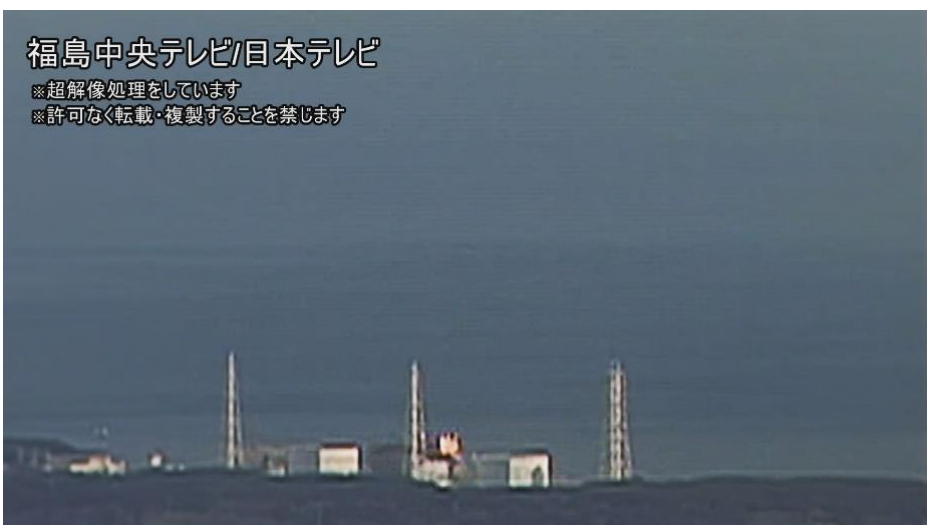
図 7 - 3 3号機における水素爆発時の原子炉建屋上部の火炎の状況 0/60 秒
