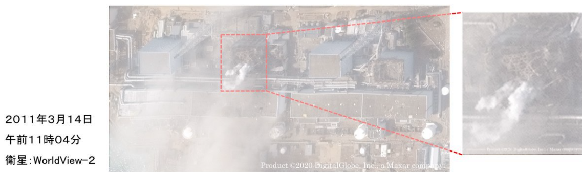
図 10 福島第一原子力発電所 1号機～4号機の衛星写真
