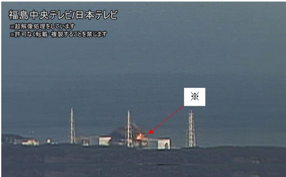
図 7-10 3号機における水素爆発時の原子炉建屋上部の火炎の状況 20/60 秒
