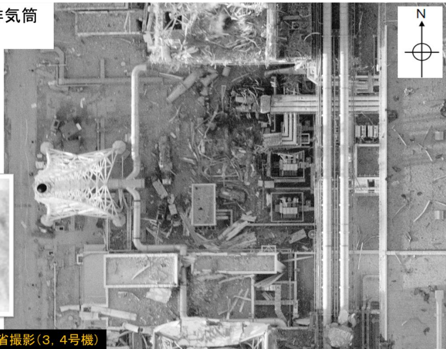
図9 3/4号機 SGTS 配管系の建屋外の状況 (航空写真)
