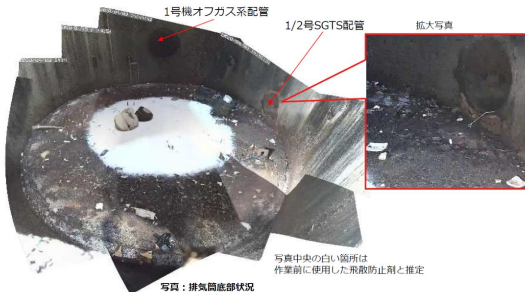
図5-6 1/2号機共用排気筒底部内側の状況(東京電力調査)
