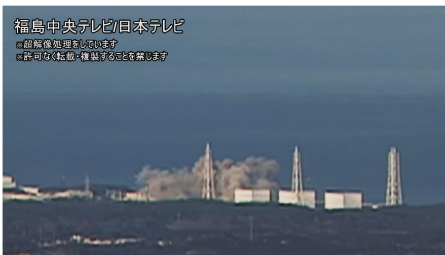
図 4—4 1号機の水素爆発における噴煙等の状況 60/60 秒
