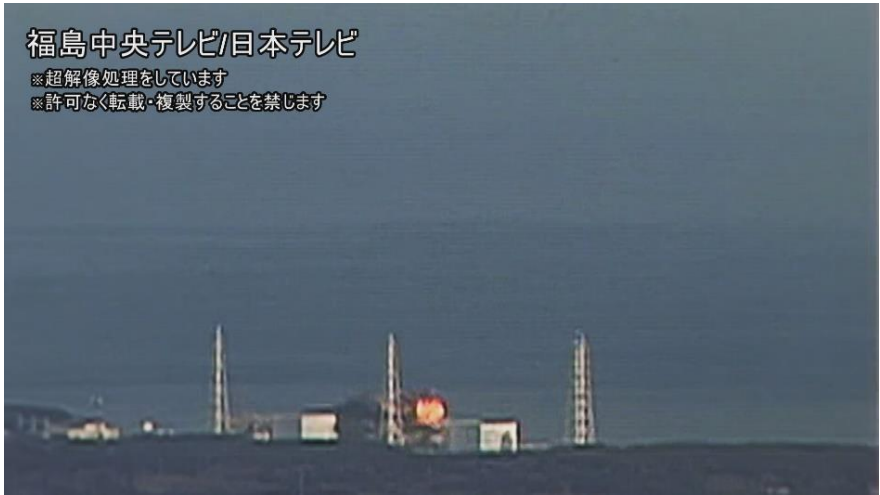
図 3 - 1 1 7 / 6 0 秒時点での 3 号機原子炉建屋
