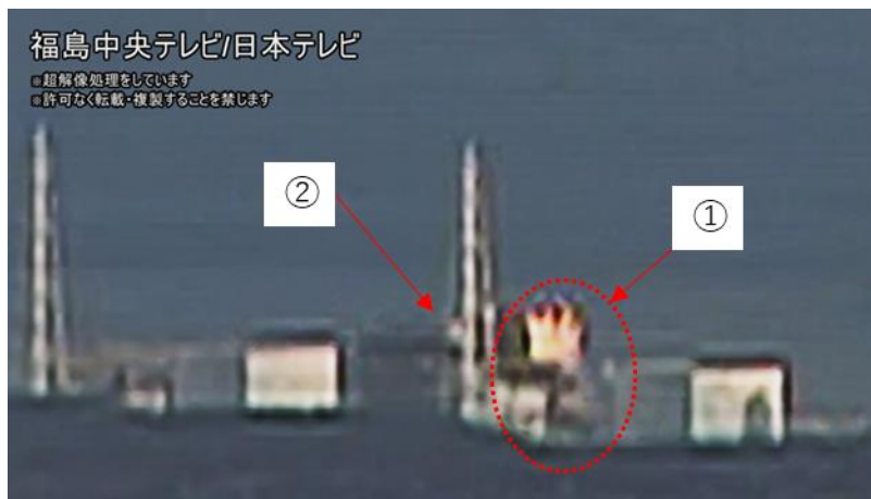
図 3-5 1/60秒時点での3号機原子炉建屋
