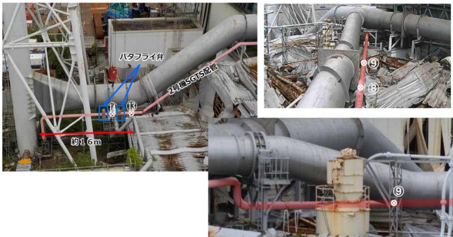
図10-1.1 SGTS配管近傍の線量調査結果(高線量箇所)(東京電力調査)
