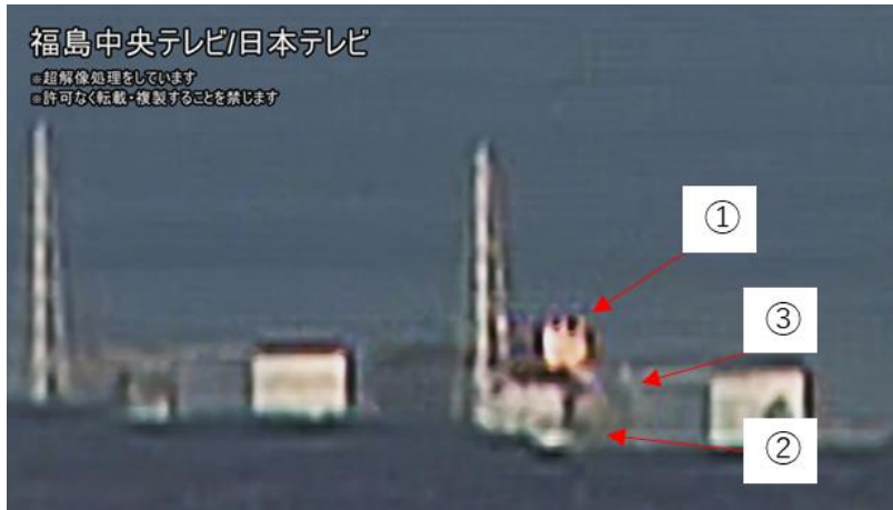
図 3-4 0/60秒時点での3号機原子炉建屋
