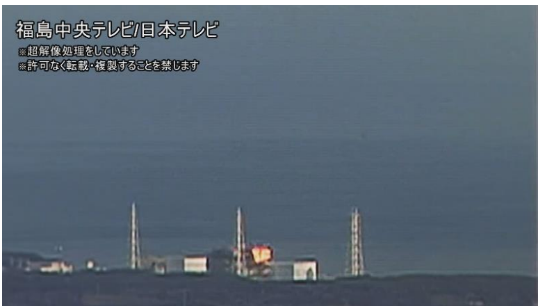
図 3-8 4 / 60 秒時点での 3 号機原子炉建屋
