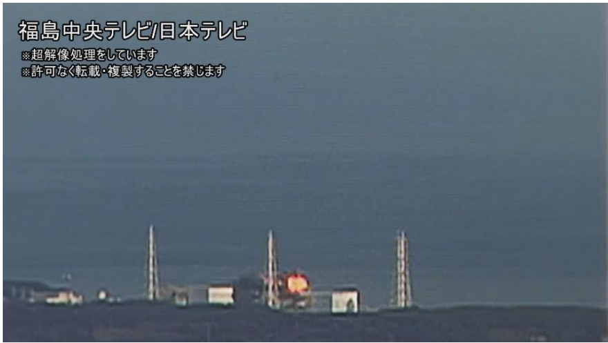
図 3 - 1 0 6 / 6 0 秒時点での 3 号機原子炉建屋
