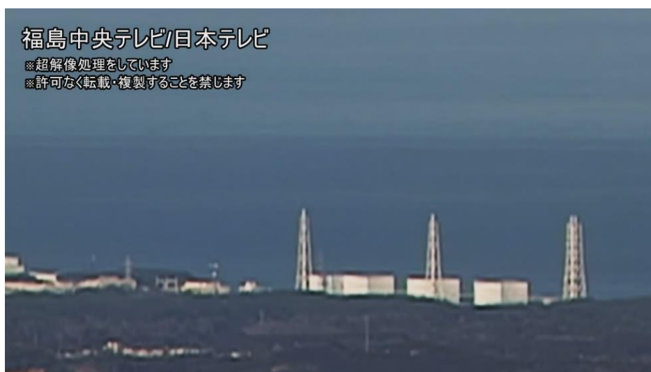
図6—1 1号機における水素爆発時の原子炉建屋上部の火炎の状況 -1/60秒
