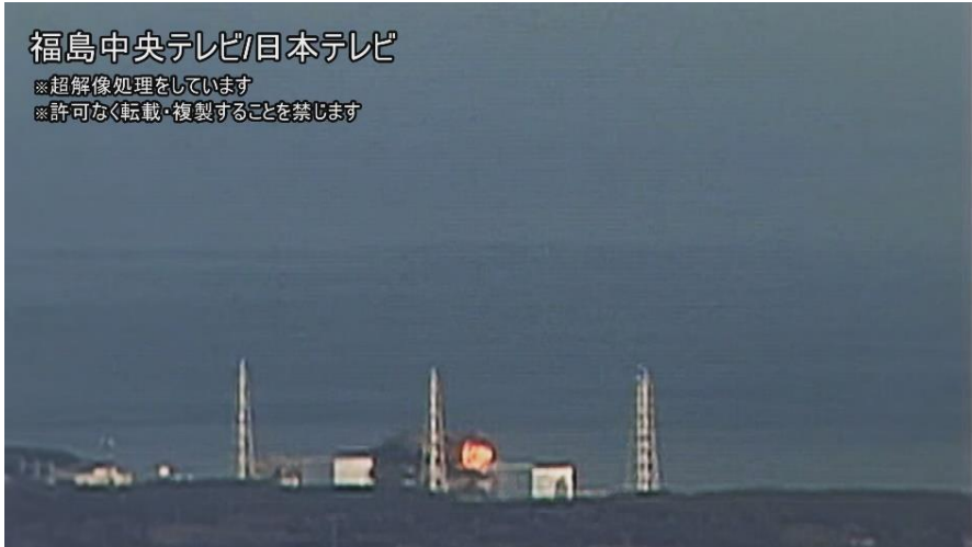
図 3-13 9/60 秒時点での 3 号機原子炉建屋
