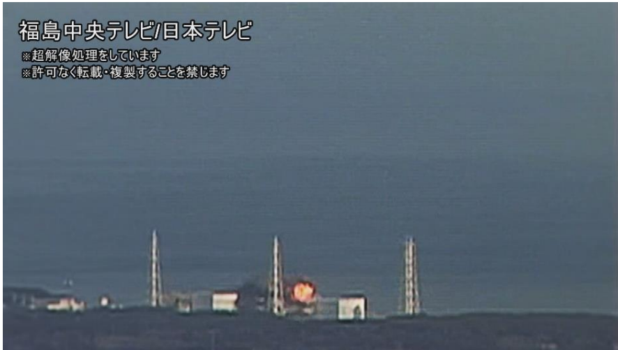
図 3-14 10/60 秒時点での 3 号機原子炉建屋
