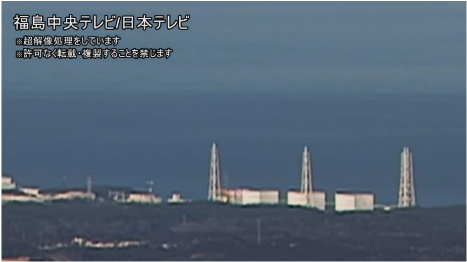
図6—2 1号機における水素爆発時の原子炉建屋上部の火炎の状況 0/60秒
