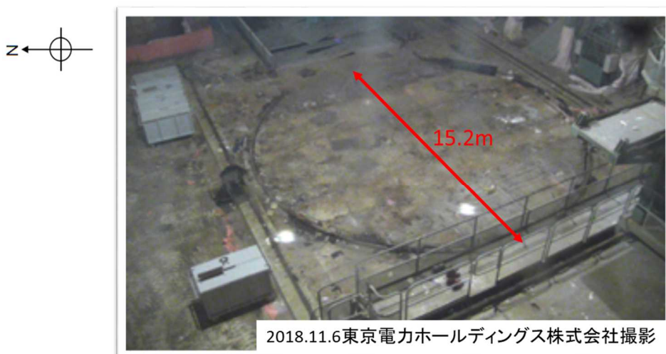
図5 2号機のおペフロの状況 (2018年11月6日)
