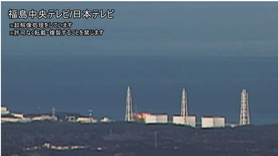
図6—3 1号機における水素爆発時の原子炉建屋上部の火炎の状況 1/60秒
