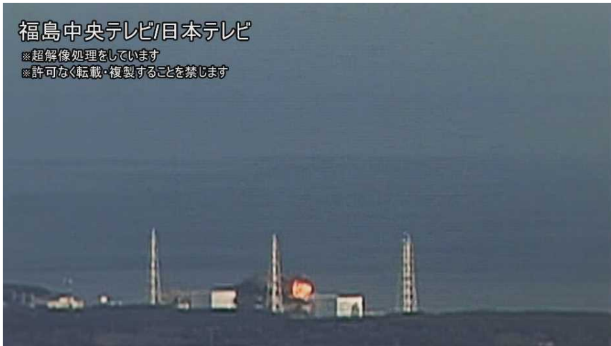
図 3 - 1 3 9 / 6 0 秒時点での 3 号機原子炉建屋
