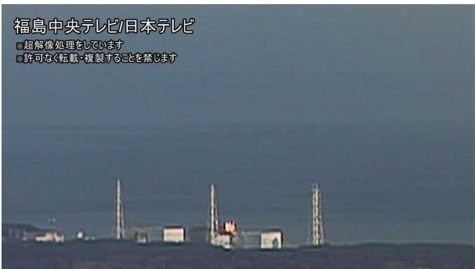
図 7 - 3 3号機における水素爆発時の原子炉建屋上部の火炎の状況 0/60 秒
