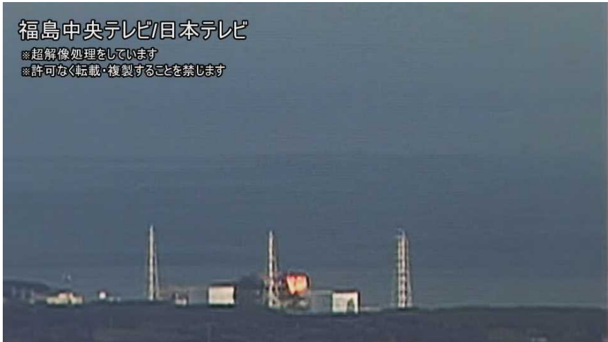
図 3 - 9 5 / 6 0 秒時点での 3 号機原子炉建屋
