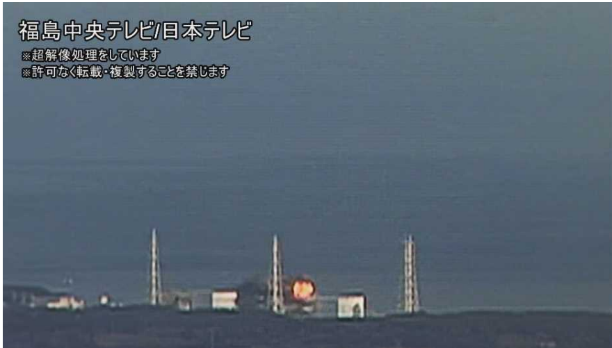
図 3 - 1 2 8 / 6 0 秒時点での 3 号機原子炉建屋
