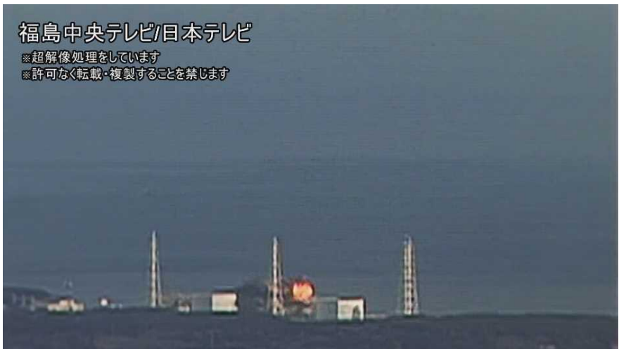
図 3 - 1 1 7 / 6 0 秒時点での 3 号機原子炉建屋
