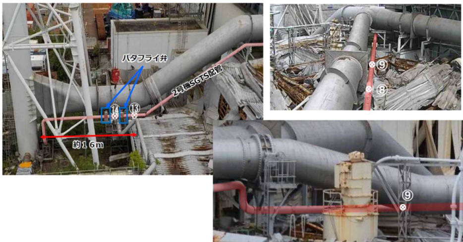
図11 SGTS配管近傍の線量調査結果(高線量箇所)(東京電力調査)
