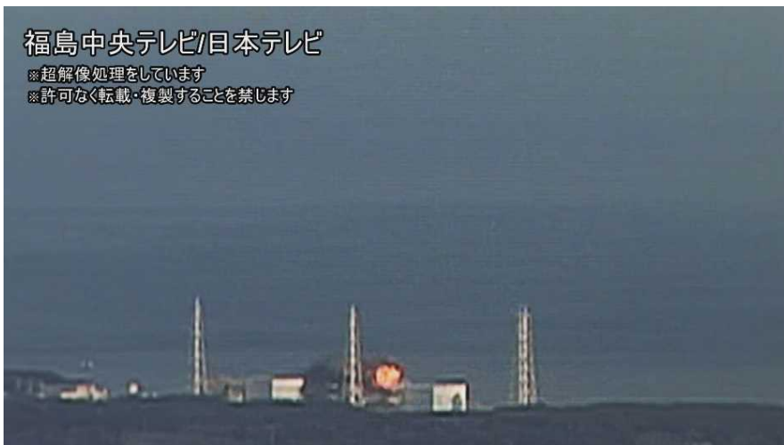
図 3 - 1 4 1 0 / 6 0 秒時点での 3 号機原子炉建屋
