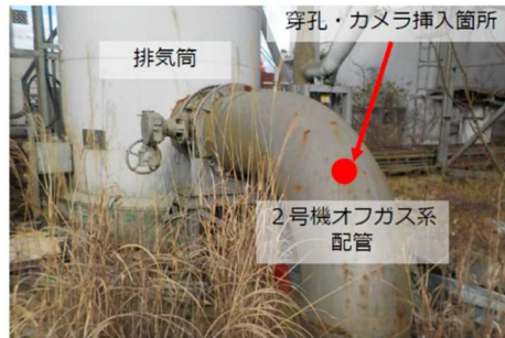
図7 排気筒内部調査の概要（東京電力調査）
