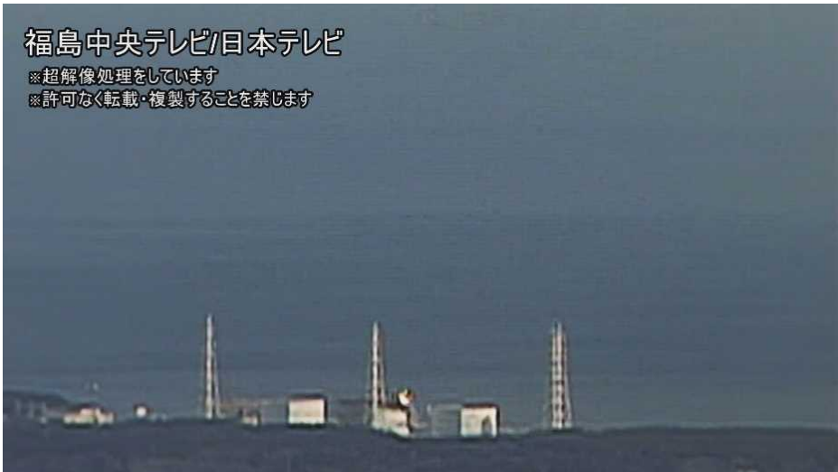
図 7 - 2 3号機における水素爆発時の原子炉建屋上部の火炎の状況 -1/60 秒
