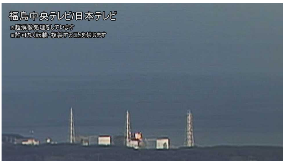
図 5-1 3号機の水素爆発における噴煙等の状況 0/60 秒
