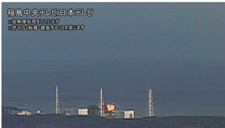
図 3-8 4 / 60 秒時点での 3 号機原子炉建屋
