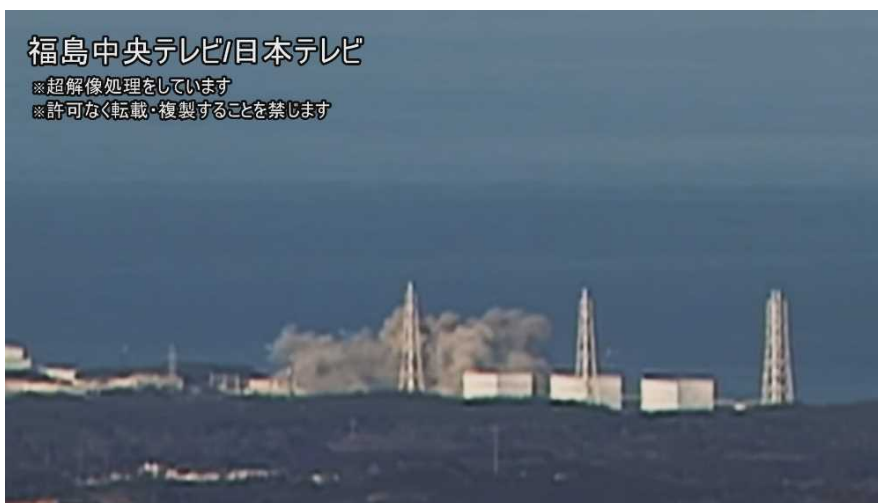
図 4—5 1号機の水素爆発における噴煙等の状況 300/60 秒
