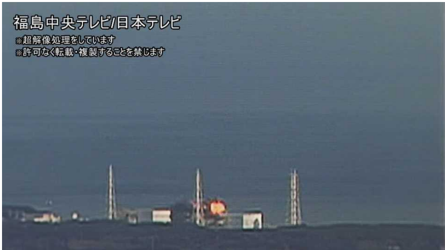
図 3 - 1 0 6 / 6 0 秒時点での 3 号機原子炉建屋
