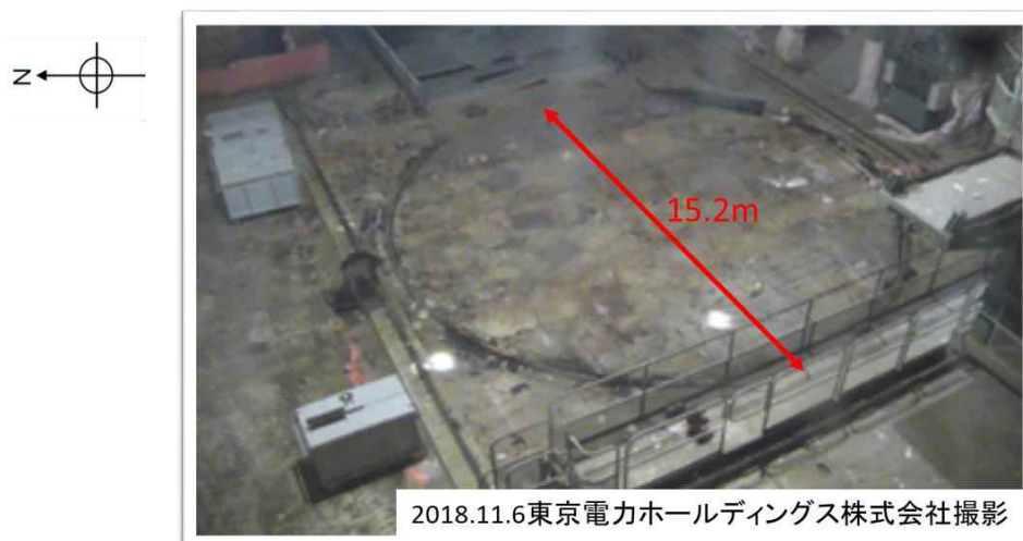
図5 2号機のおペフロの状況(2018年11月6日)
