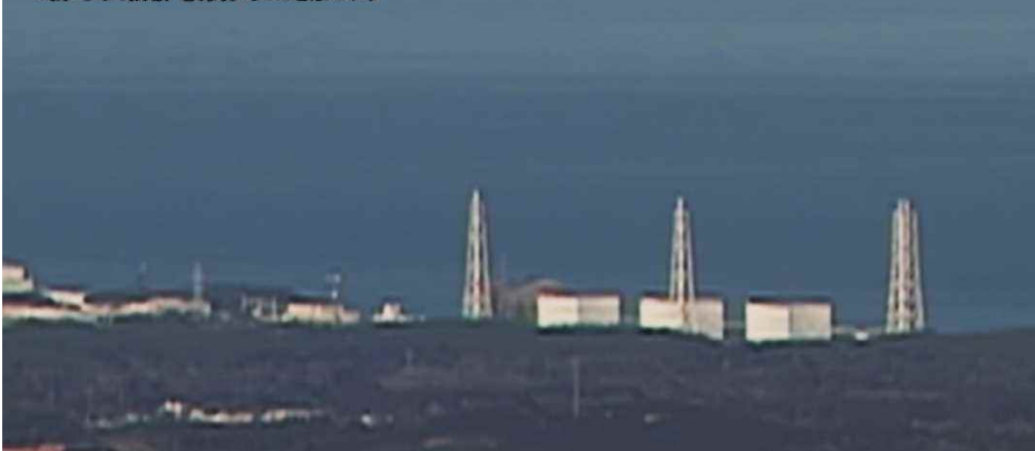
図6-6 1号機における水素爆発時の原子炉建屋上部の火炎の状況 4/60秒
