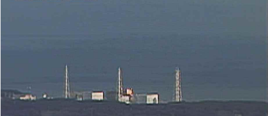
図 7 - 3 3号機における水素爆発時の原子炉建屋上部の火炎の状況 0/60 秒
