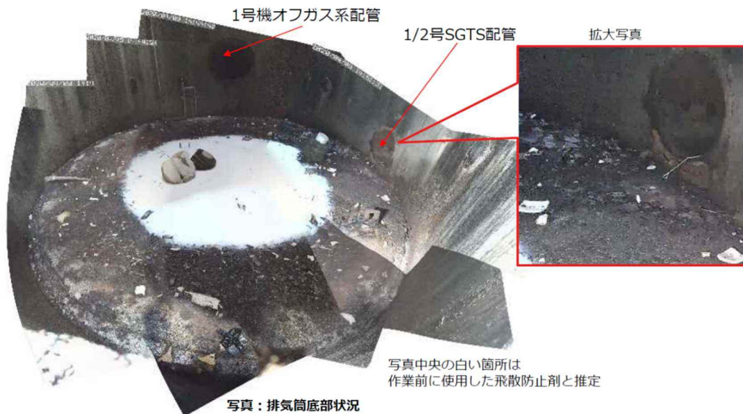
図6 1/2号機共用排気筒底部内側の状況(東京電力調査)
