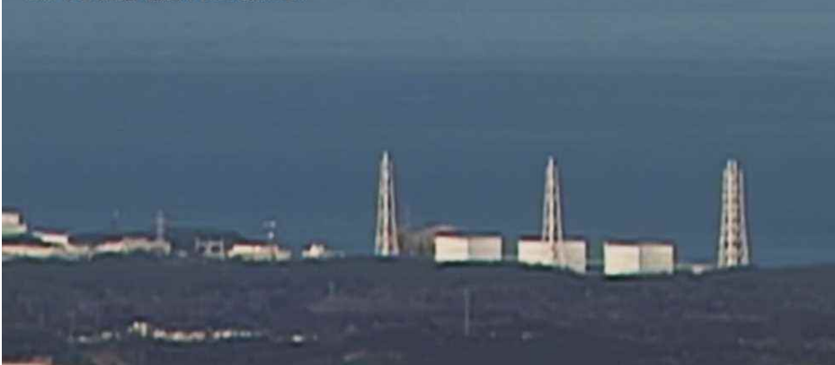
図6-5 1号機における水素爆発時の原子炉建屋上部の火炎の状況 3/60秒
