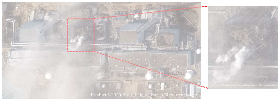
図 10 福島第一原子力発電所 1号機～4号機の衛星写真
