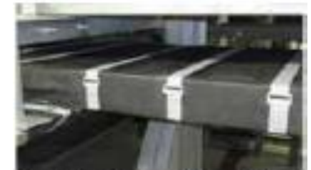
水平トレイ施工例
