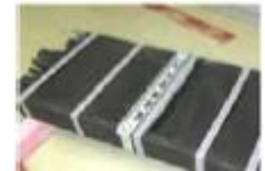
ファイアストップパの施工例
