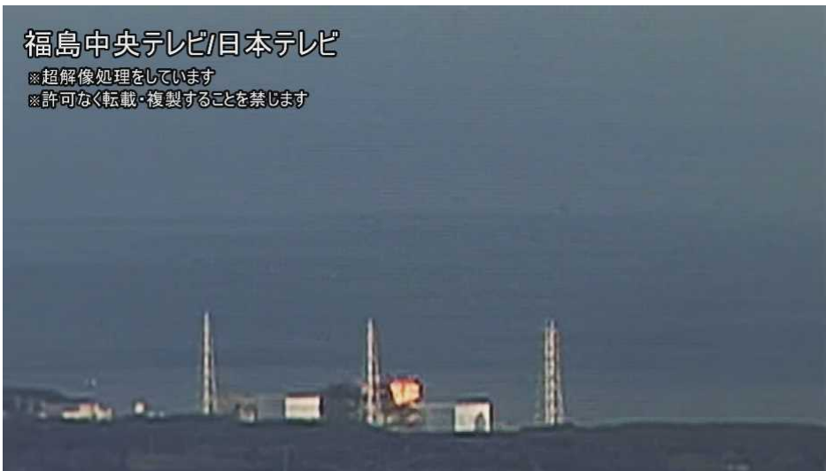
図 7-7 3号機における水素爆発時の原子炉建屋上部の火炎の状況 4/60 秒
