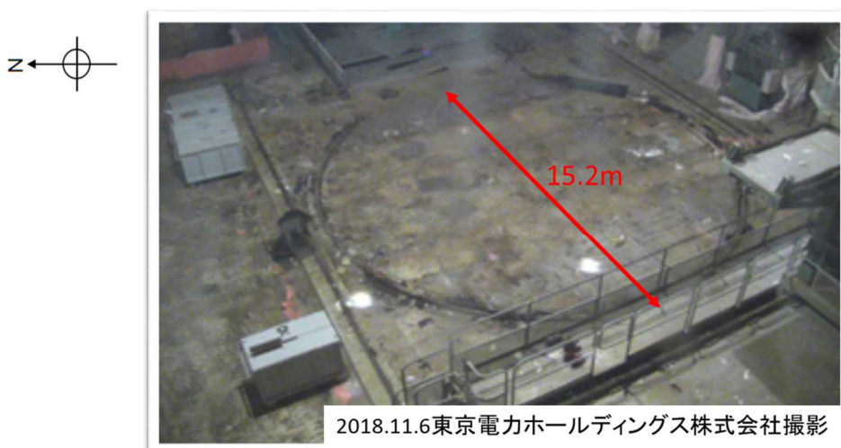
図5 2号機のおペフロの状況(2018年11月6日)
