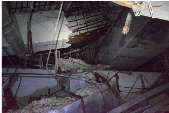
図2 3号機原子炉建屋3階天井部の小梁の損傷状況 (2019年12月の現地調査において確認されたもの)
