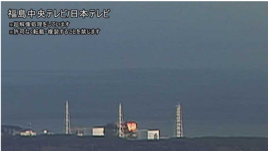
図 7-8 3号機における水素爆発時の原子炉建屋上部の火炎の状況 5/60 秒
