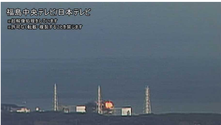
図 7-9 3号機における水素爆発時の原子炉建屋上部の火炎の状況 6/60 秒
