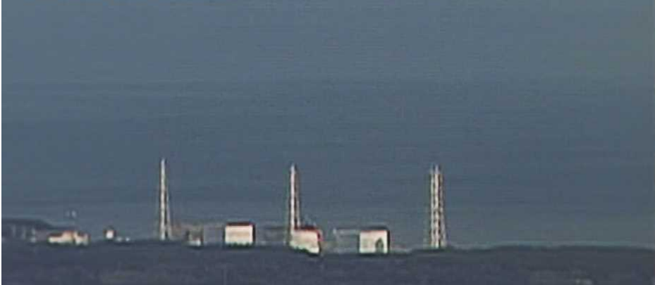
図 7 - 1 3号機における水素爆発時の原子炉建屋上部の火炎の状況 -2/60 秒
