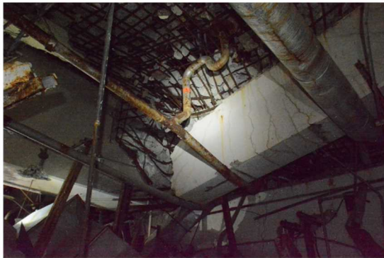
図2 3号機原子炉建屋3階天井部の小梁の損傷状況 (2019年12月の現地調査において確認されたもの)
