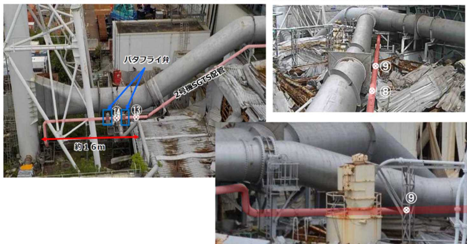
図10 SGTS配管近傍の線量調査結果(高線量箇所)(東京電力調査)
