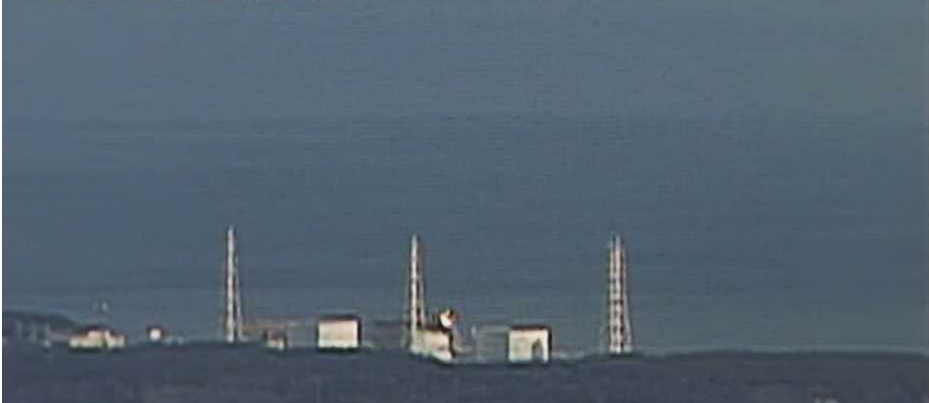
図 7 - 2 3号機における水素爆発時の原子炉建屋上部の火炎の状況 -1/60 秒
