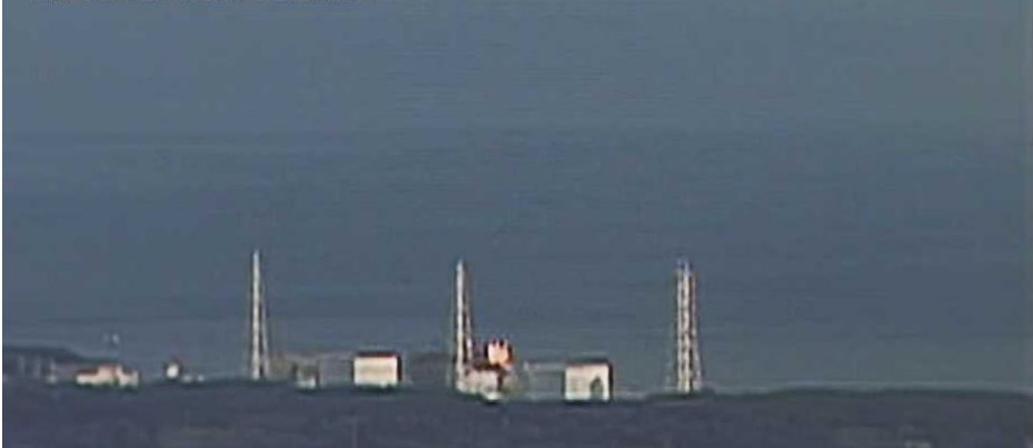
図 7 - 3 3号機における水素爆発時の原子炉建屋上部の火炎の状況 0/60 秒
