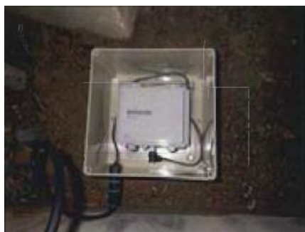
① 1階レベル （北西側構台下）
