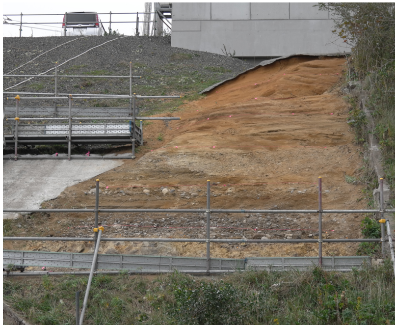
露頭拡幅部全景 (地層境界線なし)
