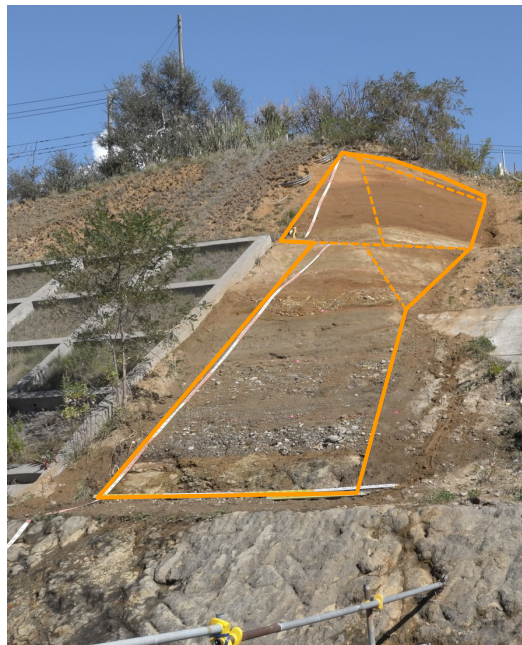
露頭状況写真
