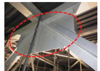
屋根トラス接合部の補強状況写真
