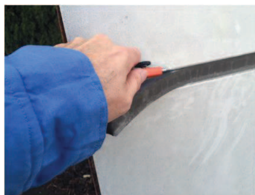
シリコーン材の切り取り状況
