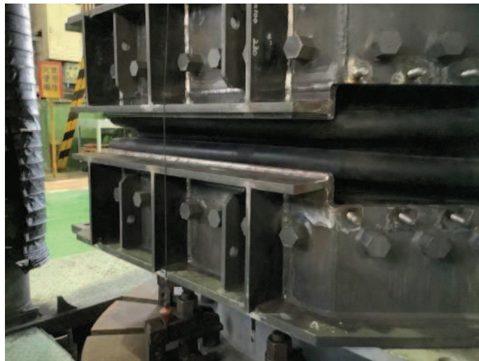
図 6.1.5-12(2) ゴムジョイント設置状況
