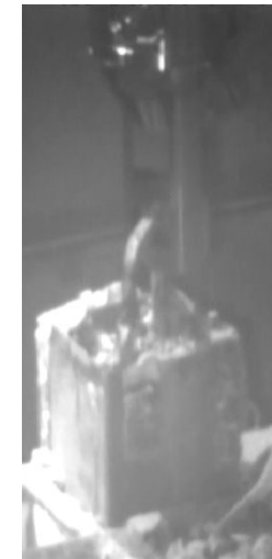
吊り上げ状況
