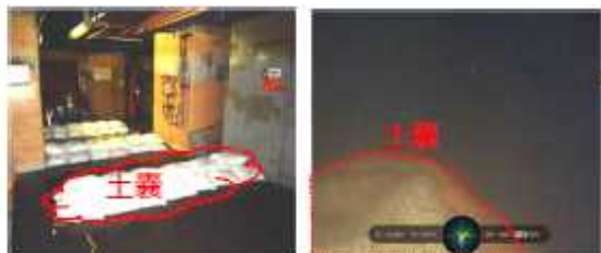
HTIの土囊状態(設置時) HTIの土囊状態(現在)
