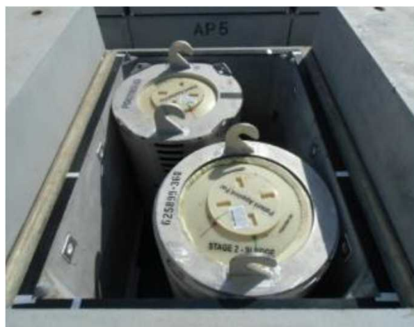
HIC入りボックスカルバート概要図(第二施設)
