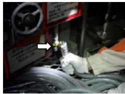
⑤仮設ホース接続
