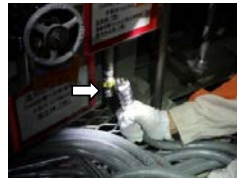
⑤仮設ホース接続
