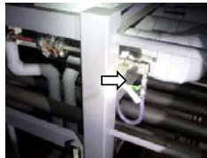
④補給水用ホース接続
