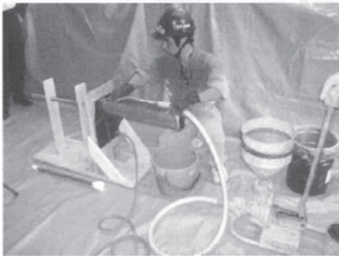
グラウトの充てん状況
