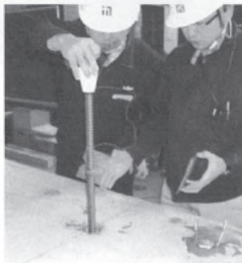
「セラミックキャップバー (CCb)」の挿入
