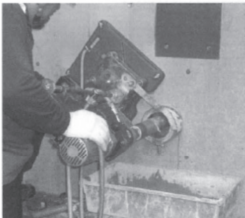
RC 部材への削孔
