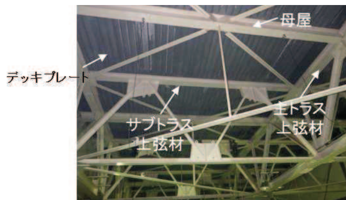
図 5.6-6 原子炉建屋原子炉棟天井の状況
