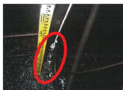
3号機水位計の例（揚水井戸⑦）
