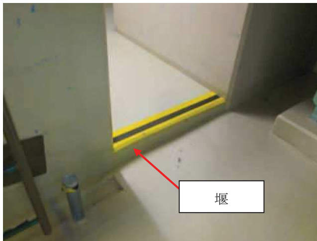
図 4-1 漏えい油の拡大防止対策の例
