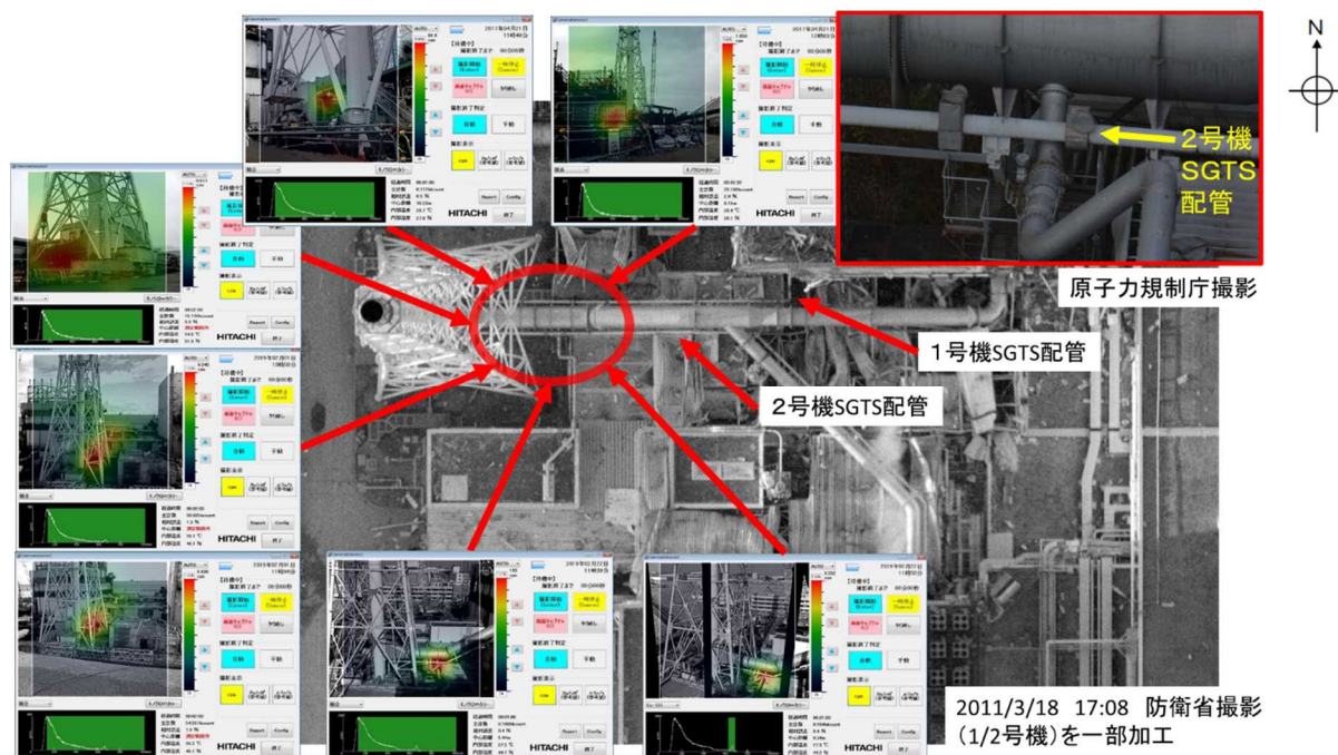
図 1－⑦ 1／2 号機 SGTS 配管の汚染状況（ガンマカメラ）
