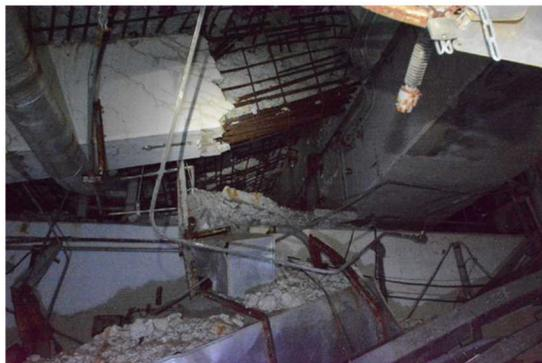
図2 3号機原子炉建屋3階天井部の小梁の損傷状況
