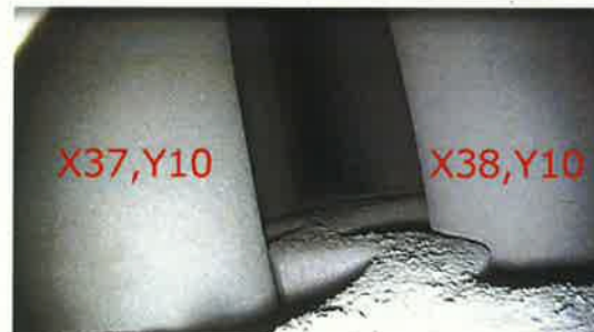
第一管支持板上
