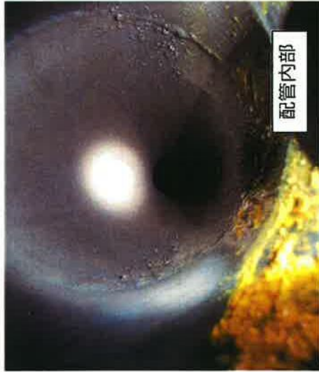
⑩-2 水位制御弁 1次側配管内部 (異物なし)
