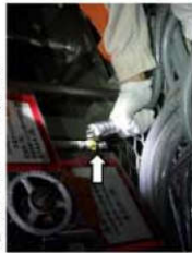
⑤仮設ホース接続
