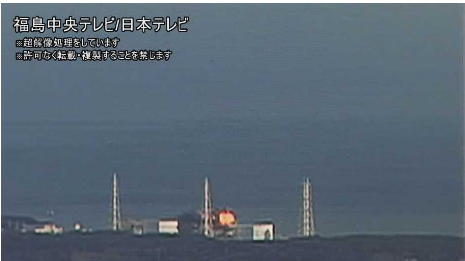
図 7-9 3号機における水素爆発時の原子炉建屋上部の火炎の状況 6/60 秒
