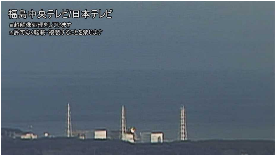
図 7 - 2 3号機における水素爆発時の原子炉建屋上部の火炎の状況 -1/60 秒
