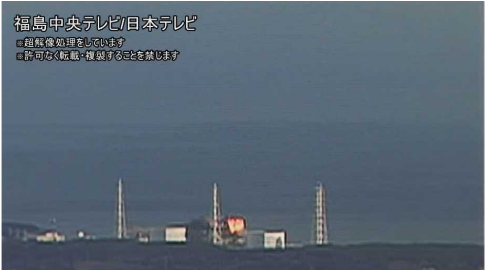
図 7-8 3号機における水素爆発時の原子炉建屋上部の火炎の状況 5/60 秒
