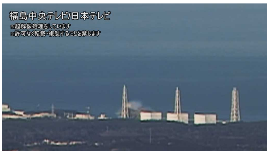
図4—2 1号機の水素爆発における噴煙等の状況 10/60秒
