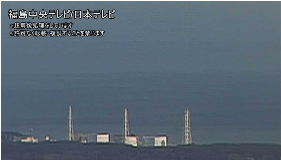
図 7 - 1 3号機における水素爆発時の原子炉建屋上部の火炎の状況 -2/60 秒
