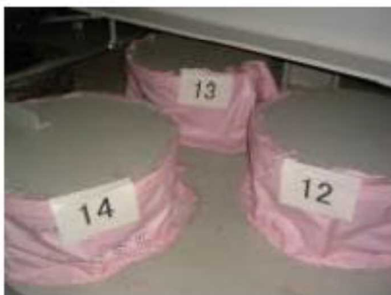
ベント管開口部の養生（東電）
