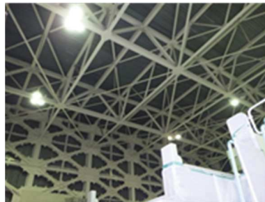
③原子炉建屋原子炉棟 3 階天井
