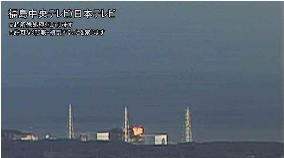
図 7-7 3号機における水素爆発時の原子炉建屋上部の火炎の状況 4/60 秒
