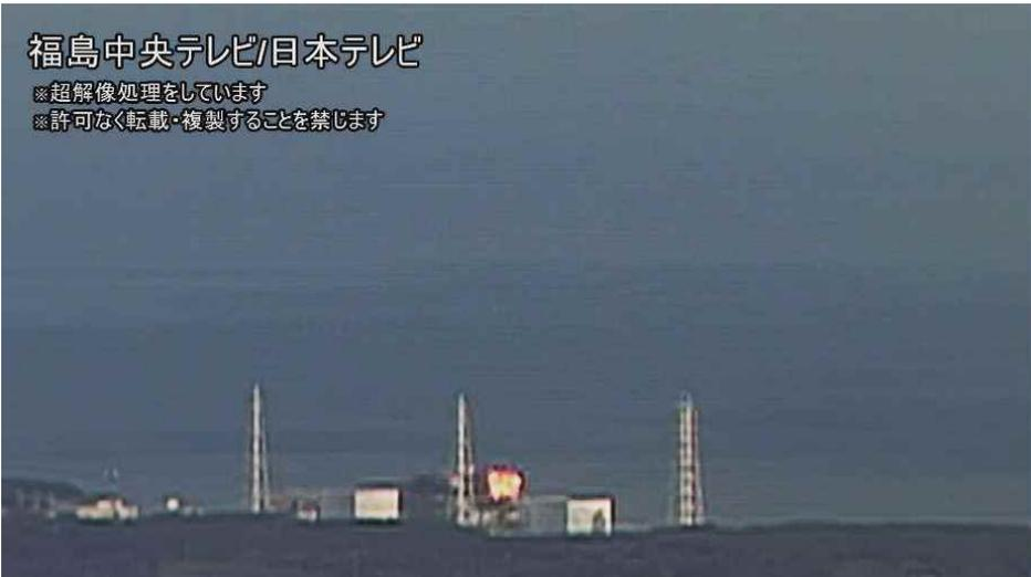
図 7-6 3号機における水素爆発時の原子炉建屋上部の火炎の状況 3/60 秒
