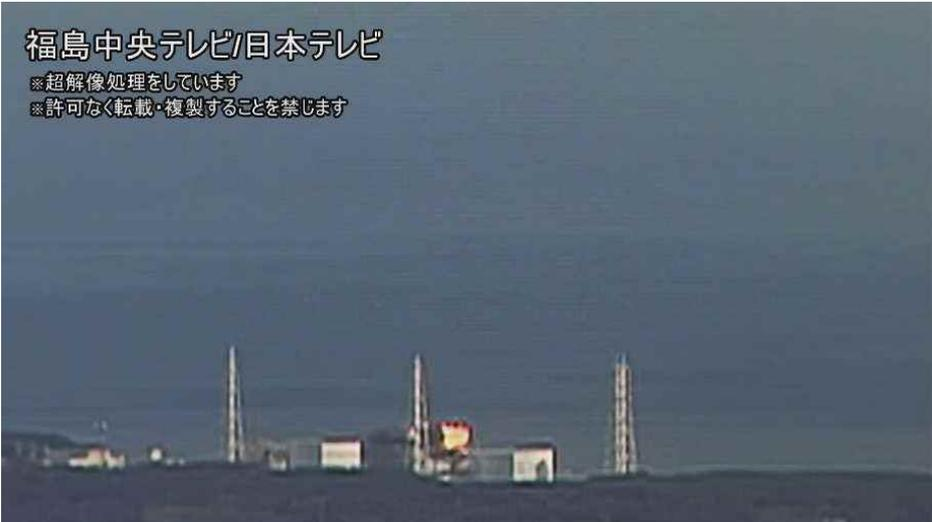
図 7-5 3号機における水素爆発時の原子炉建屋上部の火炎の状況 2/60 秒
