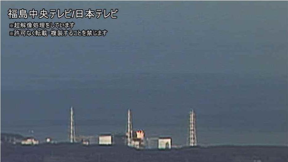
図 7-4 3号機における水素爆発時の原子炉建屋上部の火炎の状況 1/60 秒
