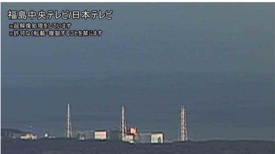
図 7 - 3 3号機における水素爆発時の原子炉建屋上部の火炎の状況 0/60 秒
