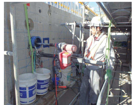
コンクリートコアドリルによる削孔状況
