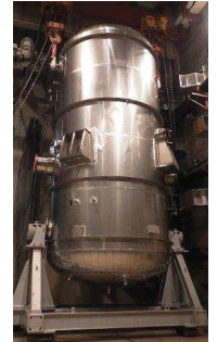
フィルタ装置(C)据付作業状況
