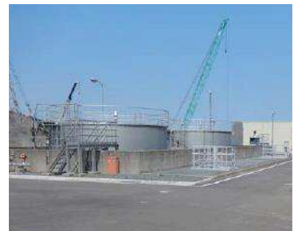
改造前 (半地下構造物)
