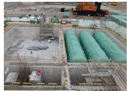
改造後 (地下構造物, タンク設置時)
