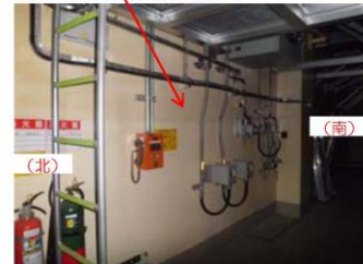
⑤基礎設置部 (東側、内部)
