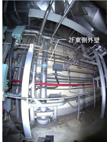
④2F東側外壁
