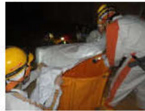
⑧給水作業
