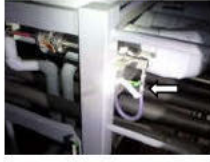
⑤仮設ホース接続
