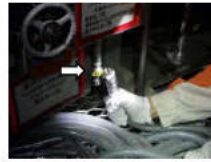
⑥仮設ホース接続
