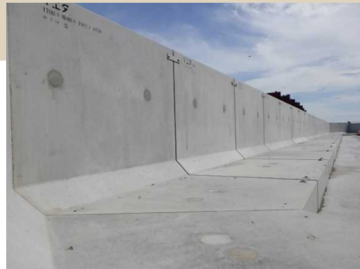
千島海溝津波防潮堤のL型擁壁の据付 (2020年9月25日完了)
