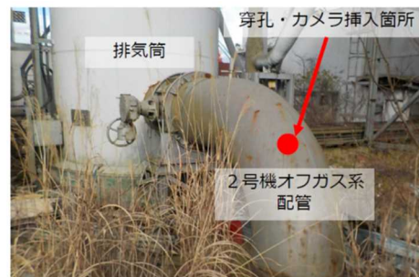
図 6 排気筒内部調査の概要 (東京電力調査)
