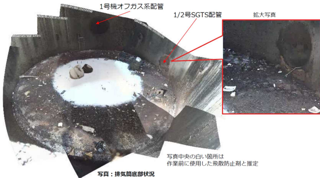
図5 1 / 2号機共用排気筒底部内側の状況 (東京電力調査)
