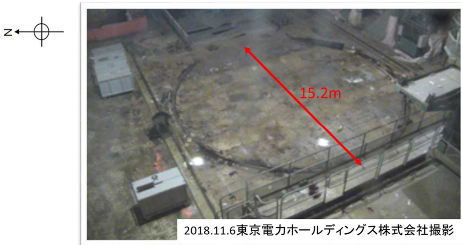
図5 2号機のおペフロの状況(平成30年11月6日)
