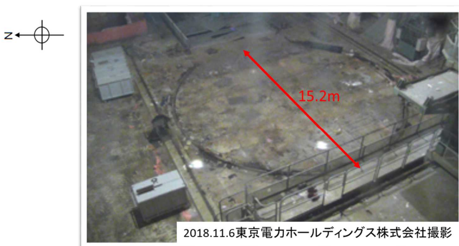
図5 2号機のおペフロの状況(平成30年11月6日)
