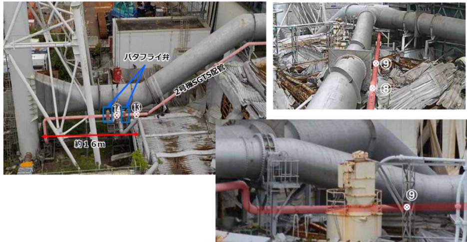
1/2号機SGTS配管撤去に向けた現場調査の実施状況について(2020年6月15日東京電力HD株式会社)より抜粋
