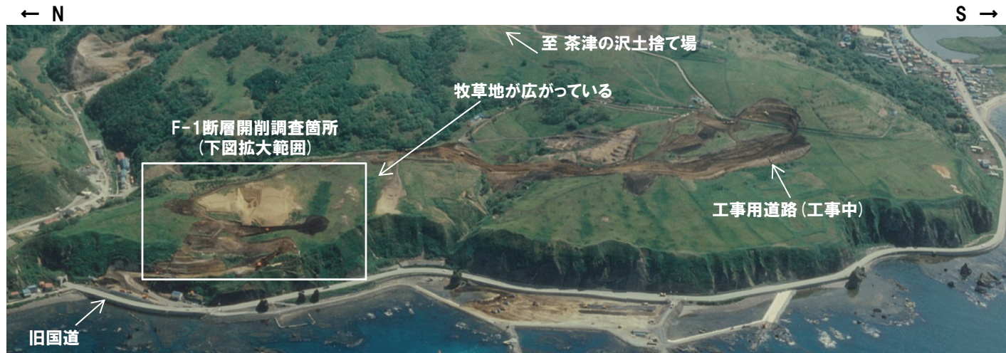
敷地の斜め空中写真 (1983年夏頃当社撮影, 注釈あり)
