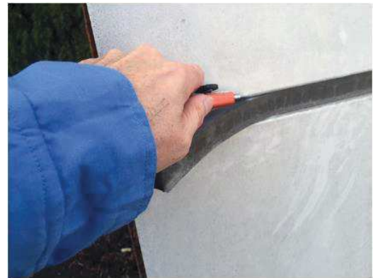
シリコーン材の切り取り状況
