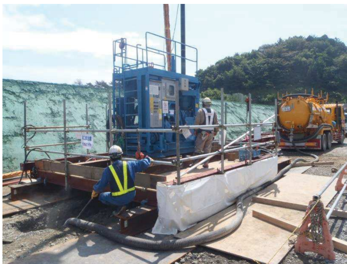
図 6.4-3 施工状況写真
