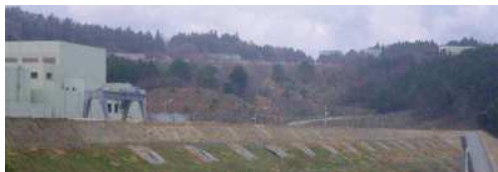
既設防潮堤完成状況 (平成24年4月26日)
