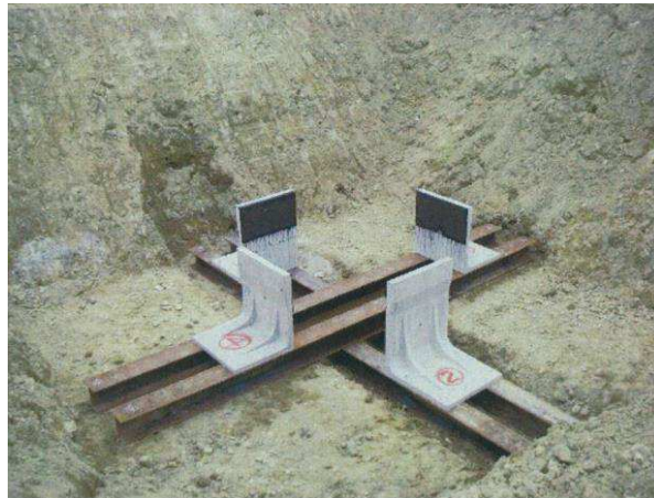
図 6.4-16 L字擁壁設置状況
