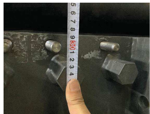
図 6.1.5-10(3) ゴムジョイント設置状況 (枠間距離計測)
