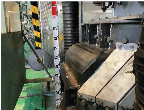
加圧状況 (漏えい無し)
