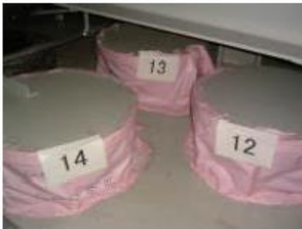
ベント管開口部の養生 (東電)
