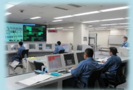
運転員の事故時訓練の充実 炉心溶融モデルを取り込んだシミュレータ訓練
