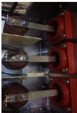
(インターロックピンの脱落による台車の飛び出し ⇒ 引き抜け) (機能喪失前) (機能喪失後)
