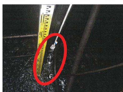
3号機水位計の例（揚水井戸⑦）
