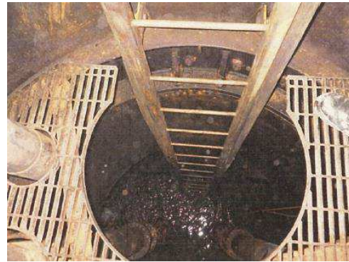
写真C 揚水井戸⑦(下段部) 2017/3/16撮影
