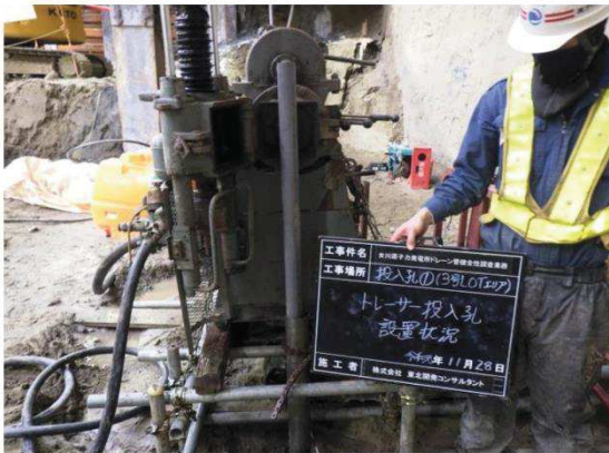
(a) 投入孔設置状況 (塩ビ管挿入)
