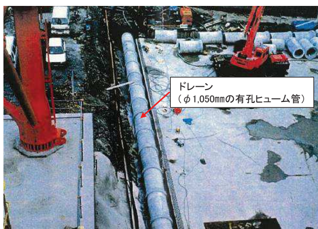
図 1-1-3 (1) 建屋外周のヒューム管設置状況
