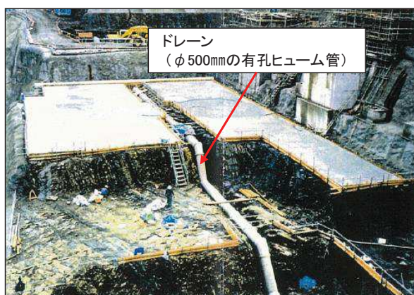
図 1-1-3 (2) 建屋等の直下のヒューム管設置状況
