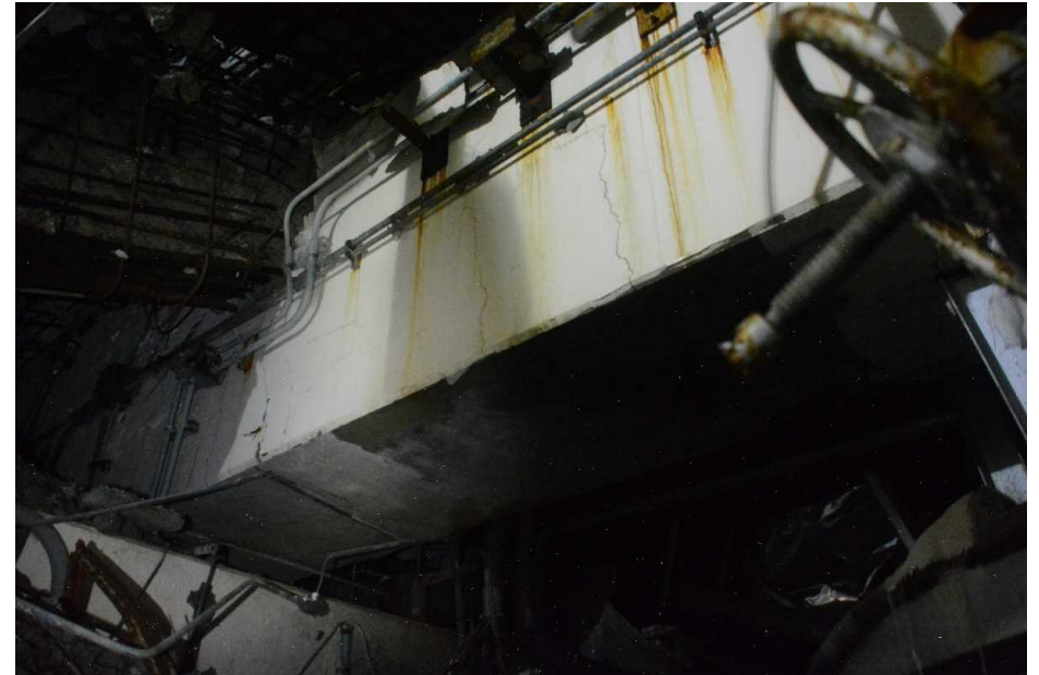
大梁Bの損傷 (No.7811)
